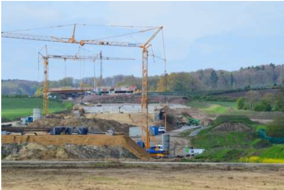
Baustelle Ortsumgehung Belm bei Osnabrück (© Bosold, BVB)
